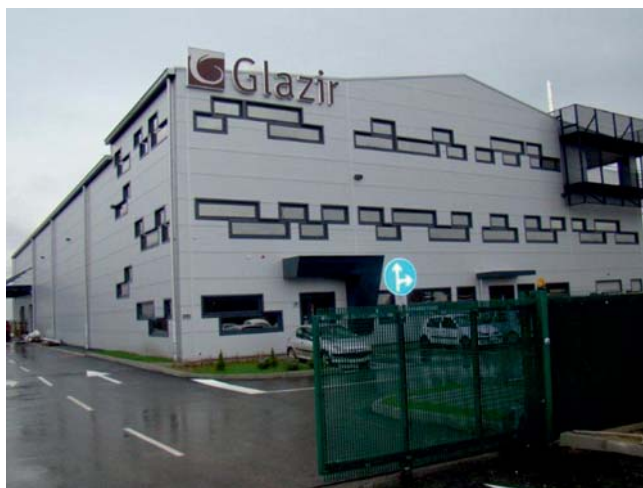
Slika 6: Izgradnja objekta u sklopu projekta „Glazir“ d.o.o. financiranog iz SAPARD programa
